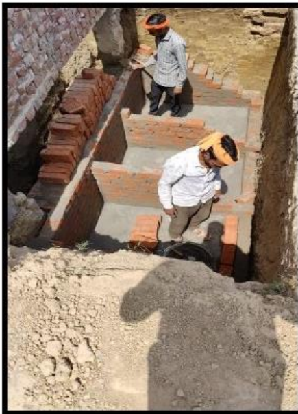
c. Construction de la fosse septique
