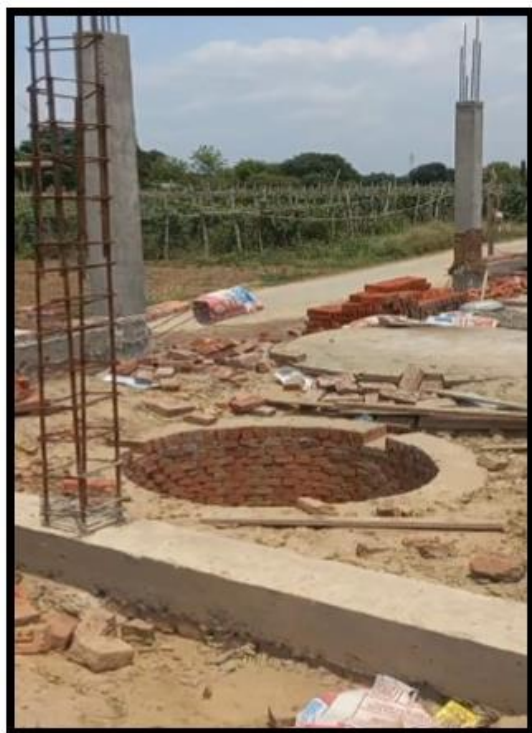
d. Construction du puisard
