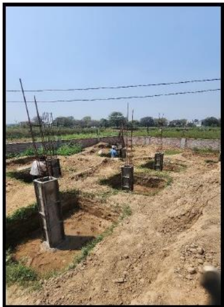
b. Mise en place des pieux
